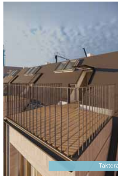
Loft med dörr mot takterass
